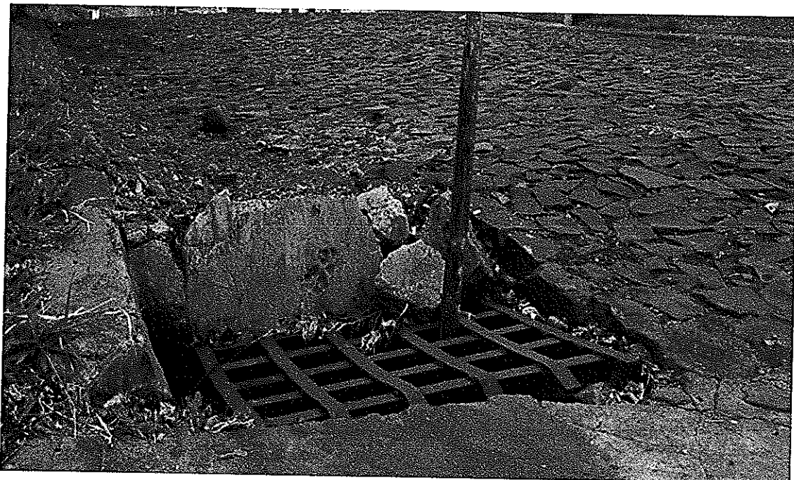
ESQUINA DA RUA MINAS GERAIS COM A RUA MARECHAL CANDIDO RONDON- BAIRRO AGUA VERDE.
